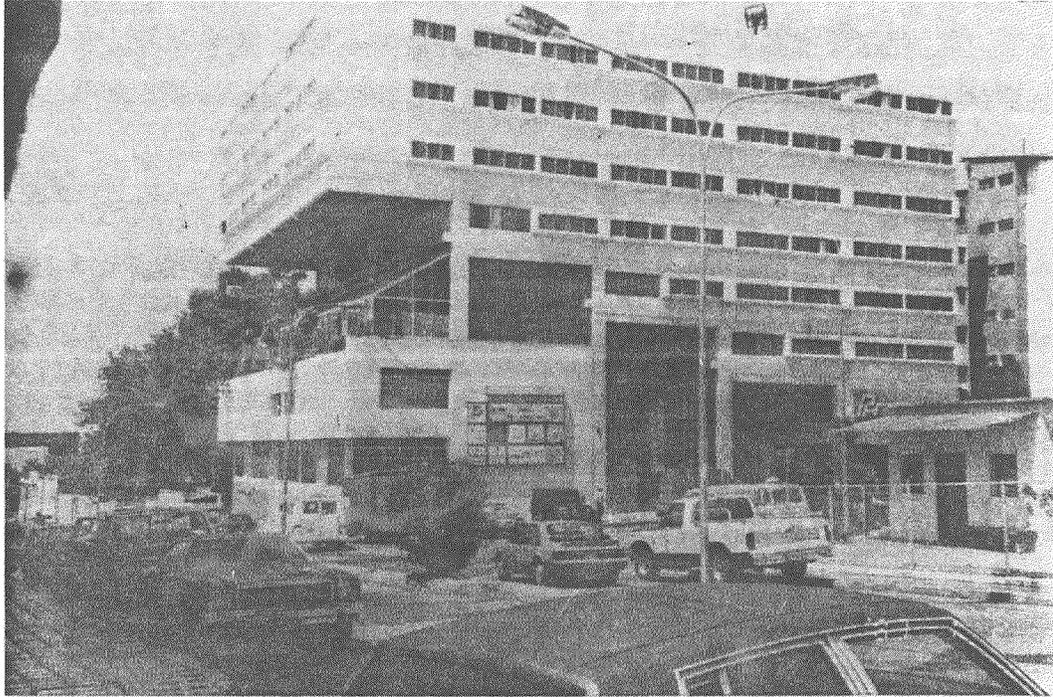
**Foto 44.- Vista general del Hotel Park localizado en el sector Glorias Patrias, el cual presenta un diseño estructural vulnerable, debido a la existencia de columnas a doble altura, columnas cortas, excentricidad.**
