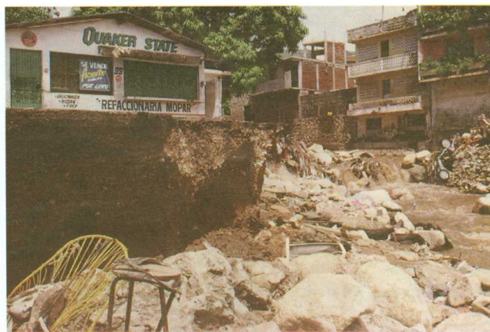
Daño ocasionado por el huracán Paulina en Acapulco, Guerrero (Fotografías: Cortesía del Ing. Roberto Durán/CENAPRED)
