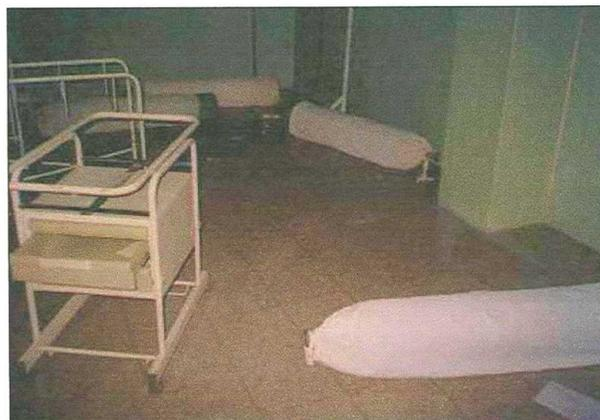
Foto 11: Caída de Cilindros de Gas por Falta de Elementos de Fijación.
