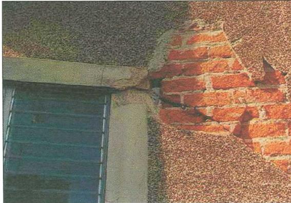
Foto 8: Detalle Agrietamiento Diagonal de Muros de Fachadas.
