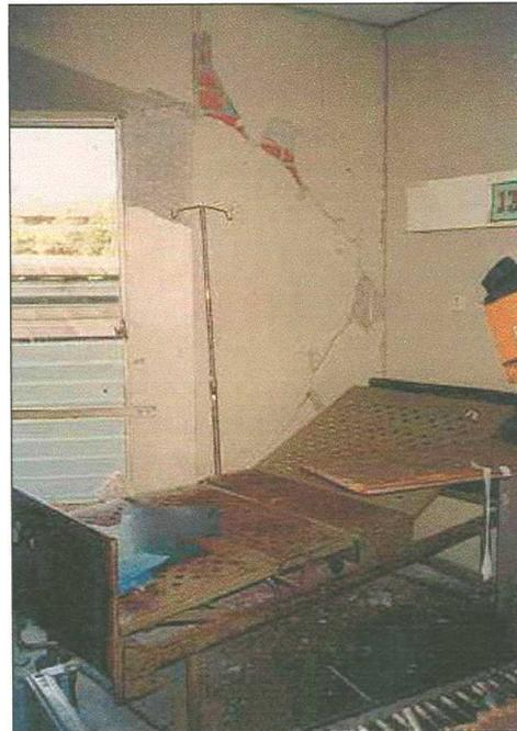
Foto 9: Agrietamiento Diagonal de Muros de Fachadas (vista interior).
