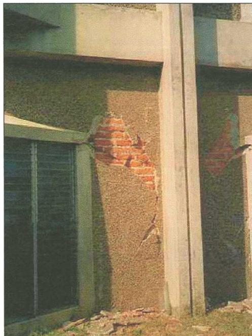
Foto 7: Agrietamiento Diagonal de Muros de Fachadas.
