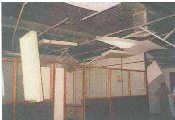
Foto 26: Colapso Total del Sistema de Cielos Falsos.
