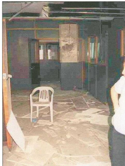
Foto 27: Colapso Total del Sistema de Cielos Falsos.
