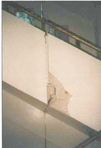
Foto 25: Daños En Juntas de Dilatación y Barandas de Escaleras.
