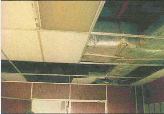
Foto 28: Interacción entre Cielos Falsos y Ductos de Aire Acondicionado.
