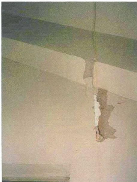
Foto 24: Daños En Juntas de Dilatación de Escaleras.
