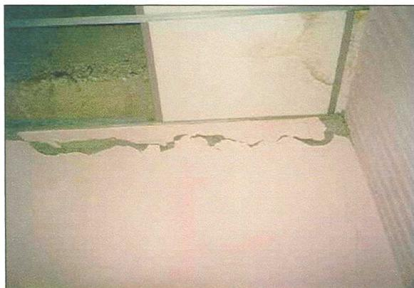
Foto 45: Daños de Repellos en el Encuentro de Muros con Vigas.
