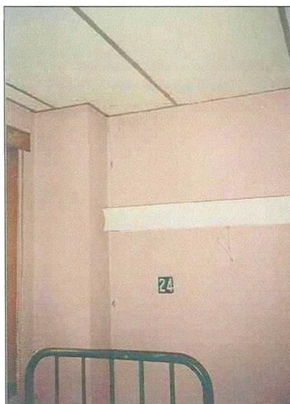
Foto 43: Daños de Repellos en el Encuentro de Muros con Pilares.
