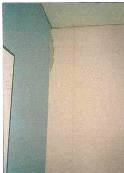
Foto 44: Daños de Repellos en el Encuentro de Muros con Pilares.
