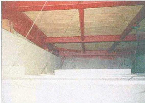
Foto 46: Sistema de Fijación de Cielos Falsos.
