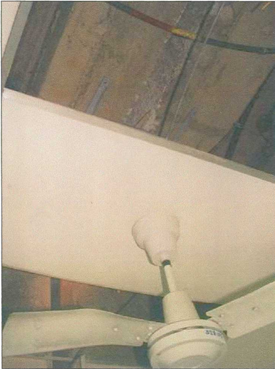
Foto 53: Luminaria Fija a Ambos Lados de Junta de Dilatación.
