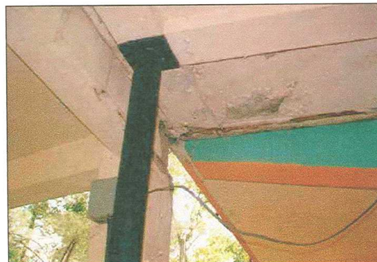
Foto 90: Junta de Dilatación Edificio Deiningering.
