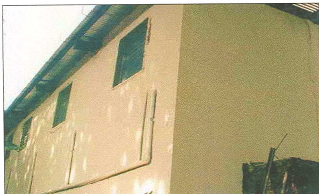
Foto 89: Fachada edificio Emergencia.
