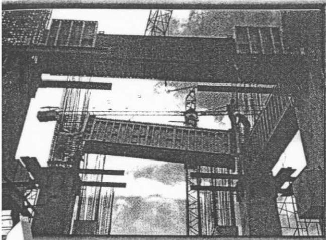
Formaleta autoportante suministrada a **SADEICO LTDA.** para la construcción de las vigas del COAL BUNKER en Termopaipa.
