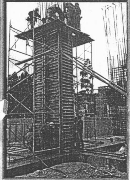
Formaleta de columnas suministrada a **SADEICO LTDA.** para la construcción del TURBINE HALL en Termopaipa.
