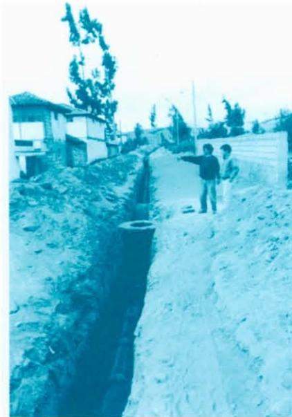
Foto 8: Alcantarillado en construcción en zona rural - Fuente: MIDUVI
