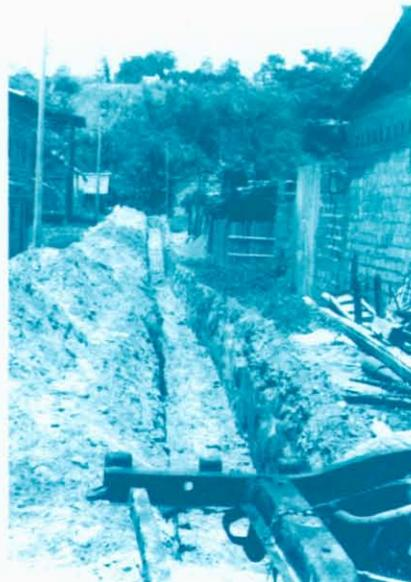
Foto 9: Tendido de tubería de alcantarillado Fuente: MIDUVI
