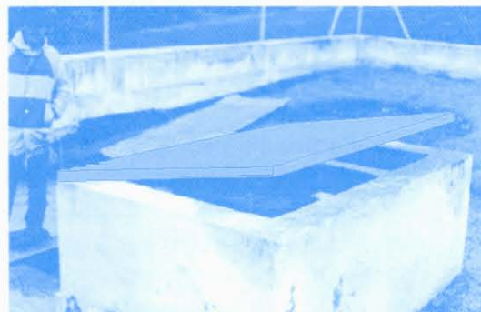
Fotos 10 y 11. Protección de captaciones Fuente: MIDUVI
