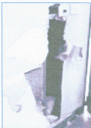
Foto 27. Daños en paneles divisorios por retención de agua en su interior. Hospital Dr. Alasia, Argentina, 2003
