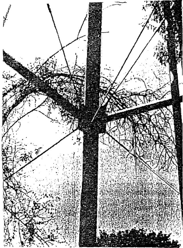
FOTO 6 Unión de elementos portantes y de arriostramientos.
