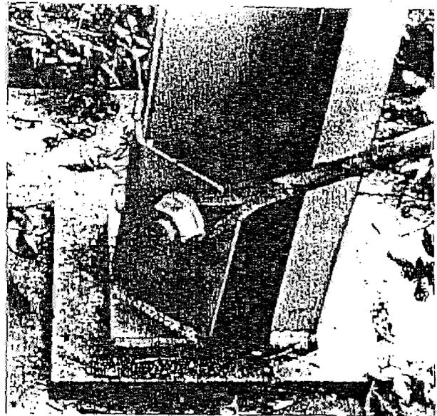
FOTO 8 Apoyo y anclaje de arriostramiento.
