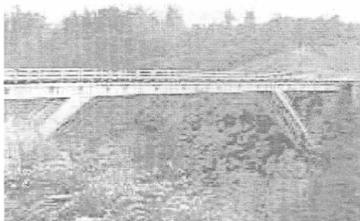
Foto 13: Pórtico Sección variable. Puente Sisga (Regional Cundinamarca).
