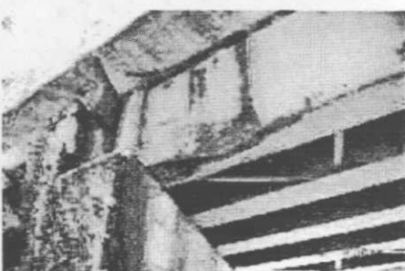
Foto 45: Corrosión e impacto, generó disminución de sección de viga. Puente Muros (Boyacá).
