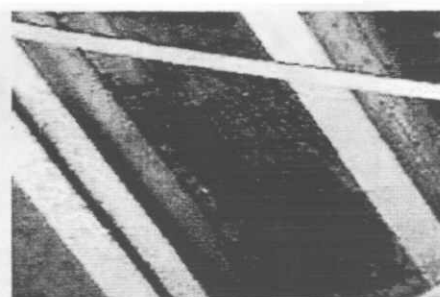
Foto 40: Acero expuesto y falta de recubrimiento. Puente Luis Ignacio Andrade (Tolima).
