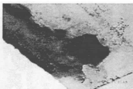
Foto 39: Problemas de infiltración y descomposición del concreto, por drenes cortos. Puente Río Cabi (Choco).
