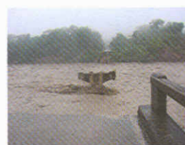
Caida del Puente Gumucio Chapare-Cbba. Fuente: VIDEICODI
