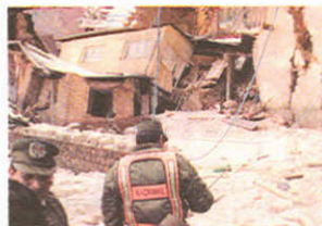
Viviendas afectadas por el granizo ciudad de La Paz Fuente: VIDEICODI
