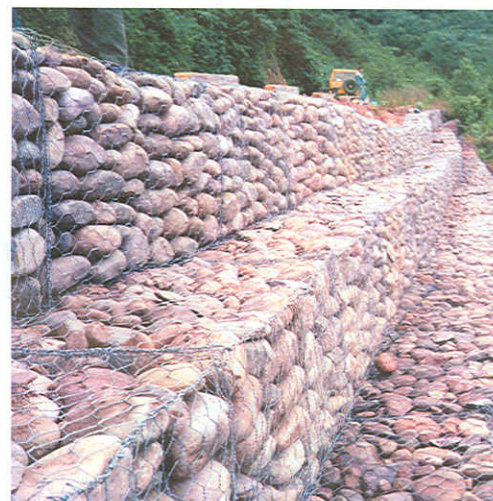
Construcción de Gaviones "El Bañado" Fuente: VIDEICICODI
