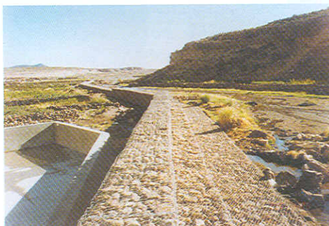
Construcción de Gaviones San Agustín - Potosí Fuente: VIDEICICODI
