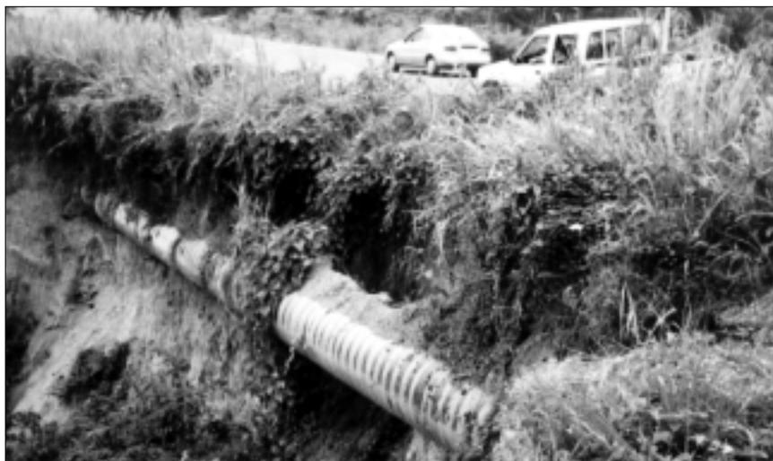
*Las obras de prevención reducen la vulnerabilidad de los sistemas. Tubería expuesta, Ecuador*
