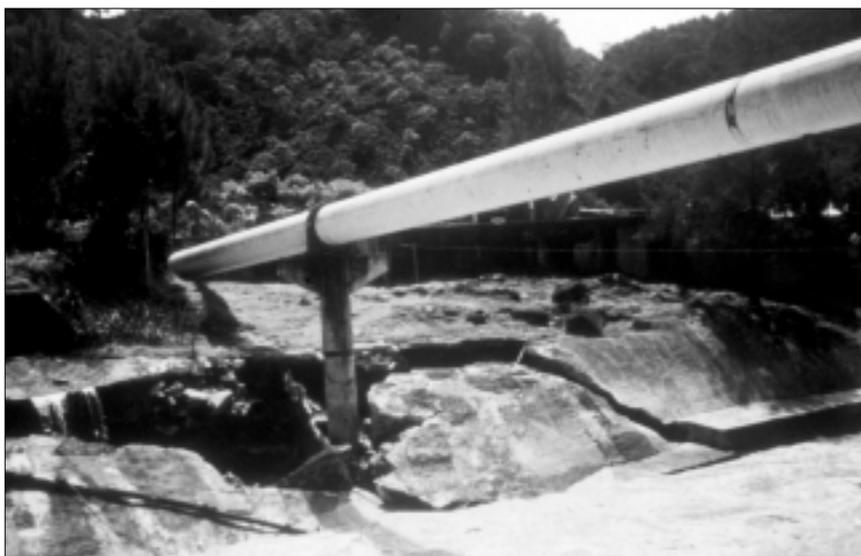
*Daños provocados en protecciones de puente para paso de tubería de línea de conducción Orosi, Costa Rica, octubre 1999. Concreto desplazado: peso 500 toneladas.*
