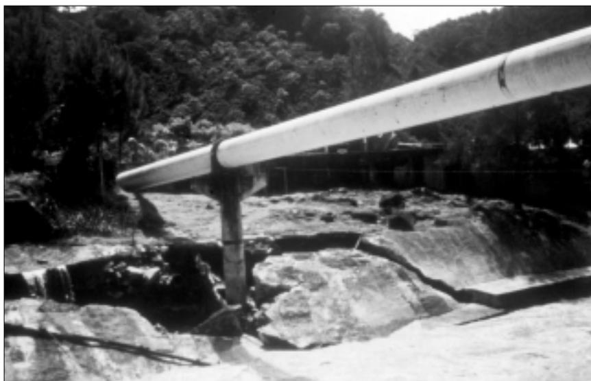
*Daños provocados en protecciones de puente para paso de tubería de línea de conducción Oroquieta, Costa Rica, octubre 1999. Concreto desplazado: peso 500 toneladas.*
