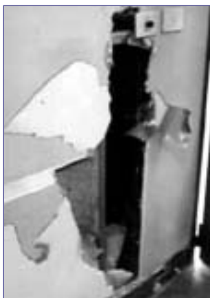
Foto 27. Daños en paneles divisorios por retención de agua en su interior. Hospital Alassia, Argentina, 2003
