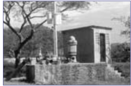
Foto 36. Bomba de impulsión de agua sobre el NCI.
