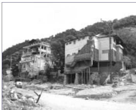
Foto 22. Destrucción de elementos estructurales como consecuencia de inundaciones. Panajachel, departamento Sololá. Guatemala, 2005.
