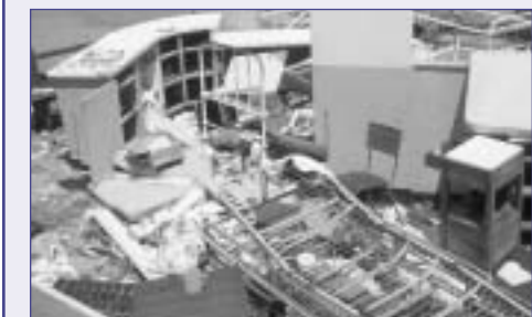
Fotos 18 y 19. los huracanes son comunes en Jamaica, y con frecuencia los vientos y la lluvia afectan las instalaciones de salud.
