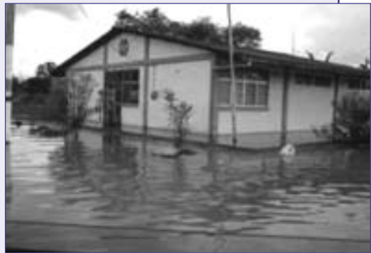
Foto 5. Centro de salud La Estancilla, inundado por lluvias causados por el fenómeno El Niño, Ecuador, 1997-1998.
