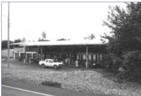
Foto 34. Protección de un edificio mediante pilotes. Sixaola, provincia de Limón. Costa Rica, 2005.
