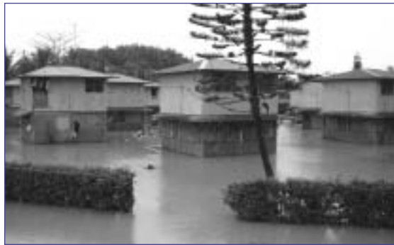
Foto 4. Efecto de inundaciones progresivas en Sixaola, Provincia de Limón, Costa Rica, 2005.
