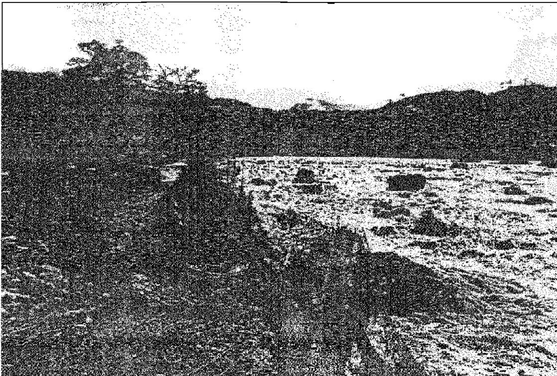
EL REVESTIMIENTO DE GAVION DE EXPANSION SUFRE LOS DAÑOS POR LA FUGA DE ROCAS Y TIERRA.
