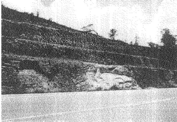
Foto No. 2 Talud que aún estabilizado a través de terrazas vegetadas, está sufriendo de erosión
