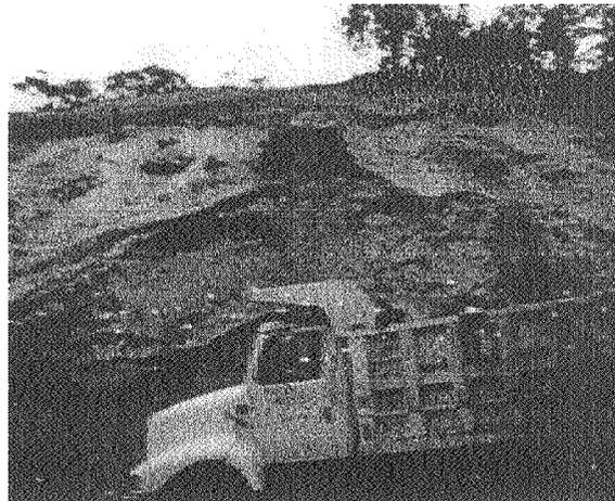
Foto No. 3 Deslizamientos y derrumbes producidos por la apertura de un camino
