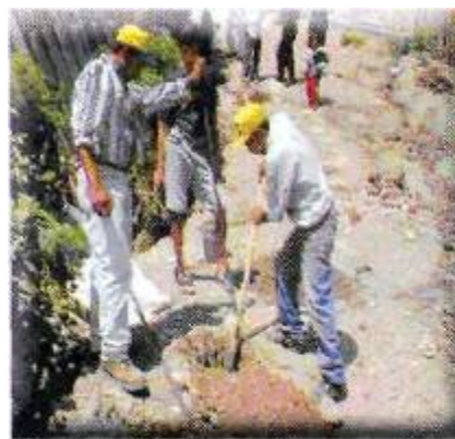
Instalación instrumentos del monitoreo del deslizamiento en Campo Cielo Installing devices to monitor the Campo Cielo landslide
